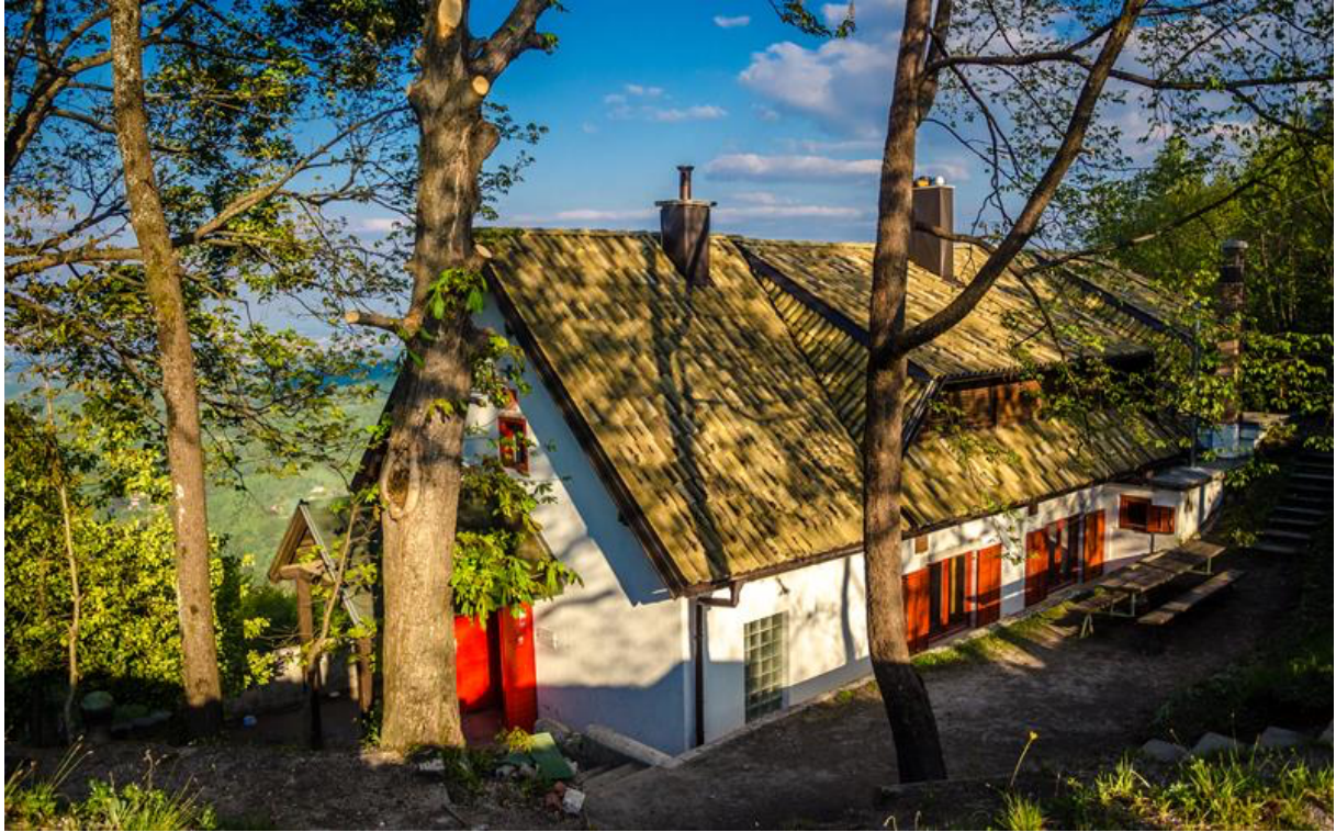
Planinarski dom Željezničar
